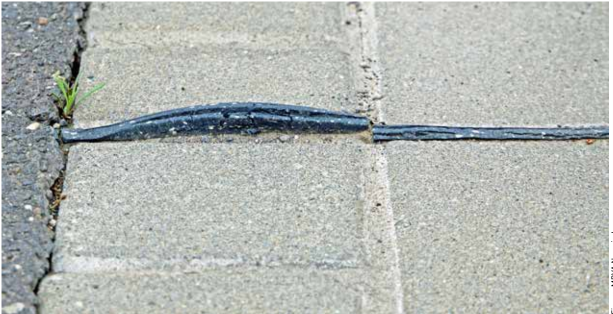
Abb. 4: Aus der Fuge herausgequetschte Fugeneinlage aufgrund von Temperaturverformungen
