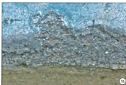
Gefügestörungen im Bereich des Wand-/Boden-Anschlusses eines Güllebehälters
