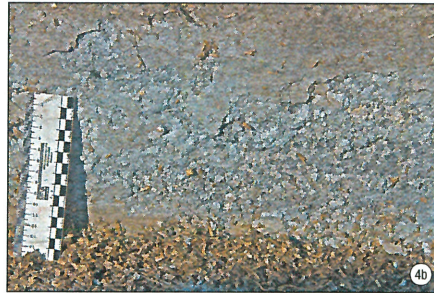
Ablösung der Beschichtung und Zerstörung der Betonoberfläche bei einer Fahrhilfsanlage
