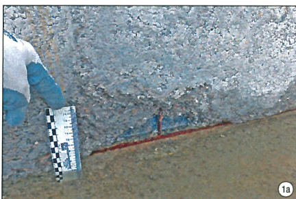
Gefügestörungen im Bereich des Wand-/Boden-Anschlusses eines Güllebehälters
