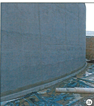
Undichtigkeiten im Bereich des Wand-/Boden-Anschlusses eines Güllebehälters
