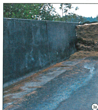
Risse und Ablösungen bei einer Fahrlochanlage
