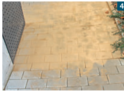
4 und 5 Beeinflussung des Erscheinungsbildes durch die Verschmutzung einer Pflasterdecke
