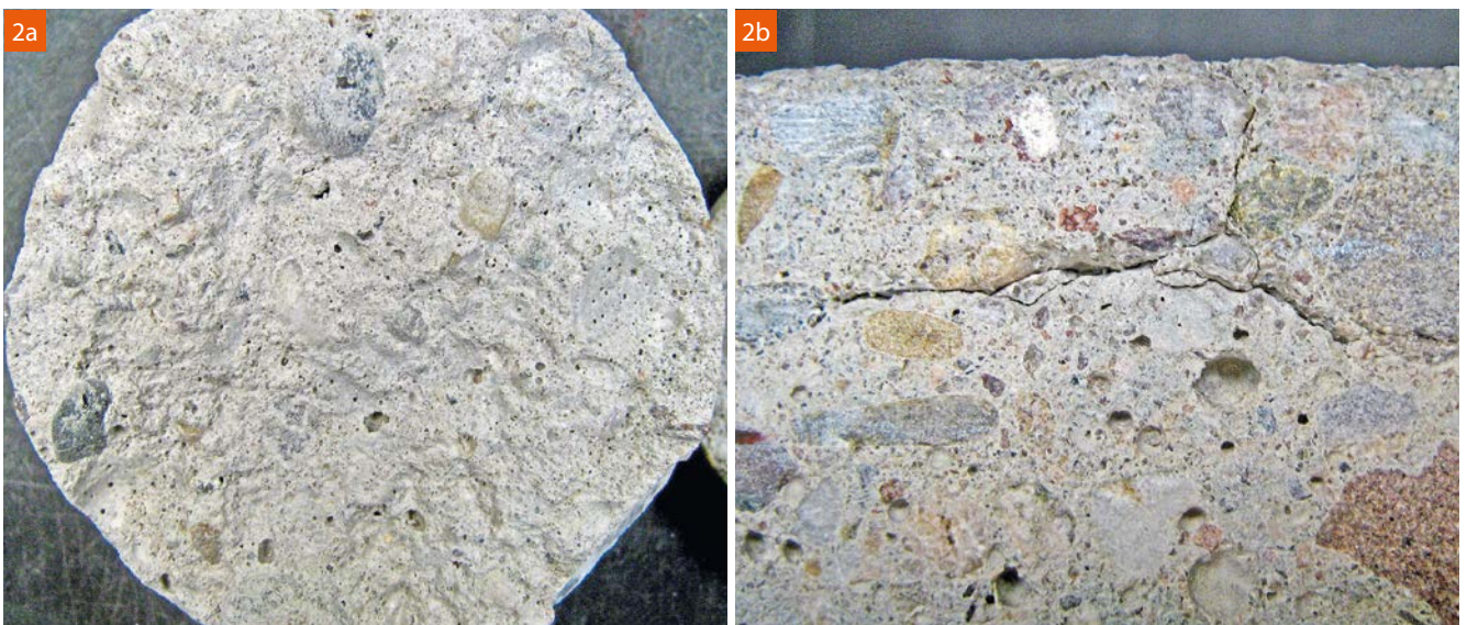
Abb. 2a und 2b: Bild Rissbildung sowie erkennbare Poren.
