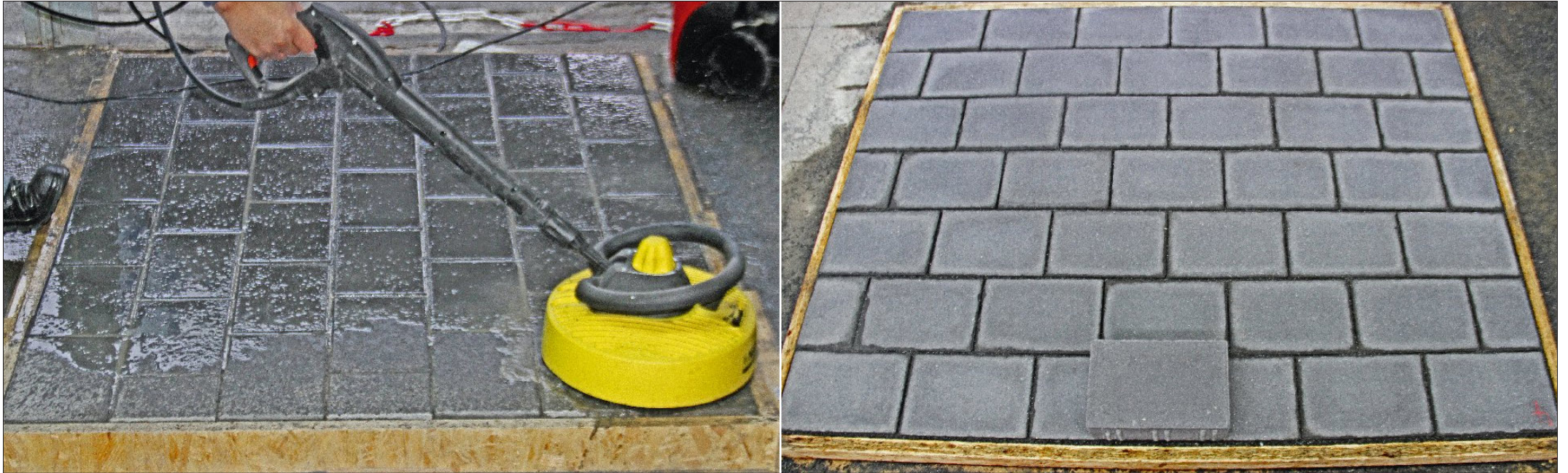
Bild 5: Links: Reinigung mit einem Niederdruck-Flächenreiniger. Rechts: Verfärbung nach der Reinigung mit dem Niederdruck-Flächenreiniger.
