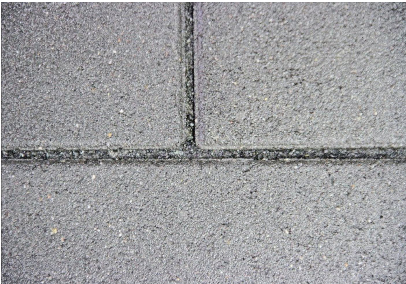
Bild 6: Fugenfüllung nach der Reinigung mit einem Niederdruck-Flächenreiniger.
