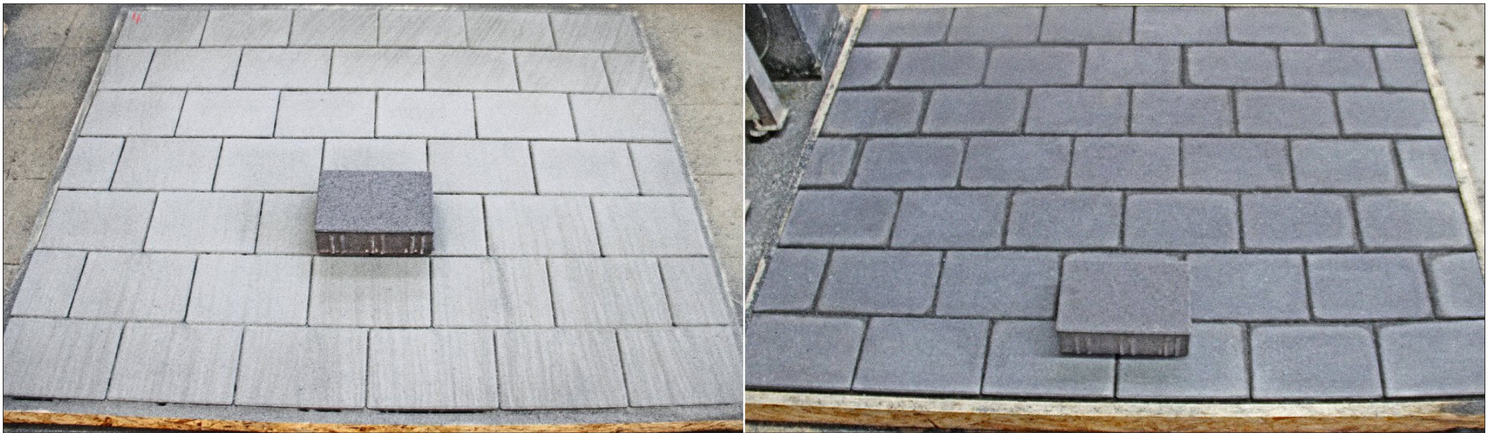
Bild 4: Links: Verfärbung nach der trockenen Reinigung. Rechts: Verfärbung nach der nassen Reinigung.
