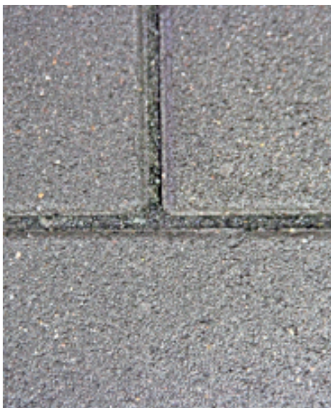
Abbildung 7: Fugenfüllung nach der Reinigung mit einem Niederdruck-Flächenreiniger.
