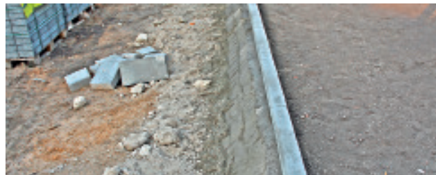
Abbildung 8: Übliche Verdichtung von Rückenstützenbetonen.
