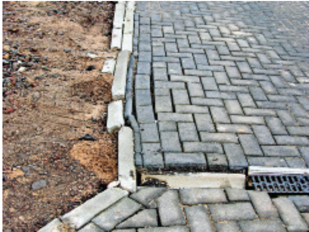
Abbildung 9: Verschiebungen aufgrund eines nicht lagestabilen Rückenstützenbetons.
