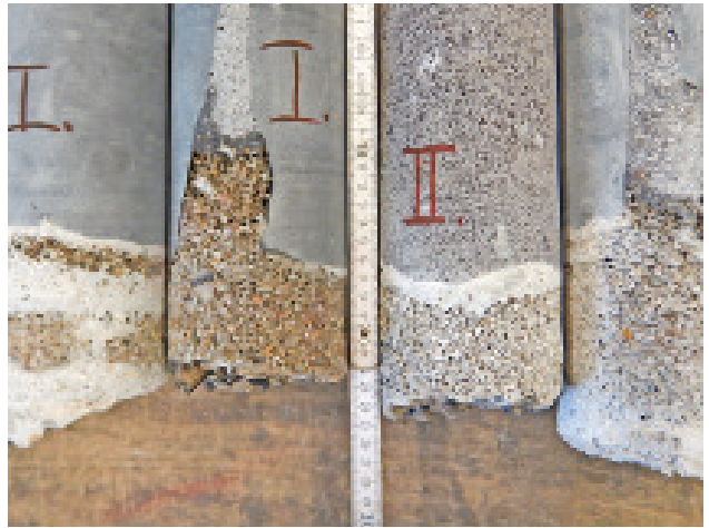
Abbildung 10: Bohrkerne zum Nachweis von Bauwerksproben.
