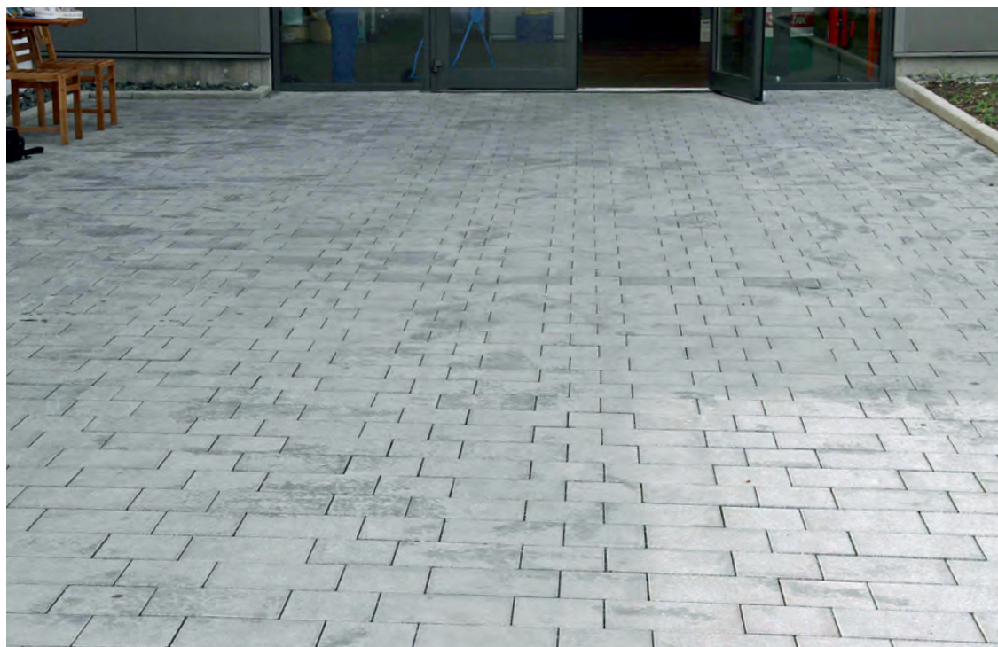
1. Verfärbung einer Steinoberfläche durch die Verwendung eines Fugensandes mit mobilisierbaren Eisenanteilen. Fotos: Voß
