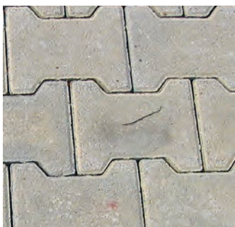
1. Verfärbung einer Steinoberfläche durch die Verwendung eines Fugensandes mit mobilisierbaren Eisenanteilen. Fotos: Voß
