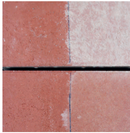
8. Aufhellung einer mit Fugenmaterial beaufschlagten Oberfläche nach der Reinigung durch trockenes Abfegen (o. re.) beziehungsweise einer nassen Reinigung (u. re.).
