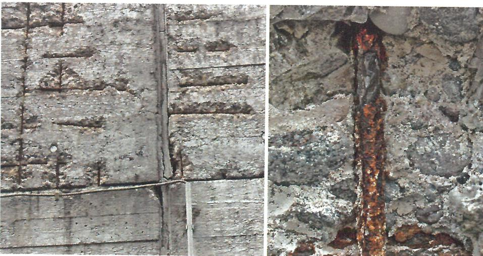
Bild 1: Korrosion des Bewehrungsstahls
