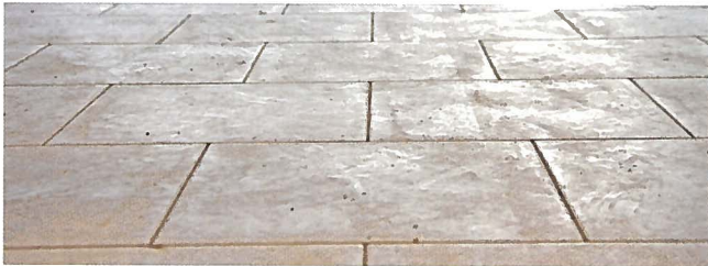
Bild 9: Sachgerechte Höhenversätze benachbarter Platten.
