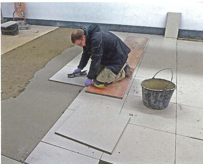
Bild 4: Einbringung großformatiger Platten.
