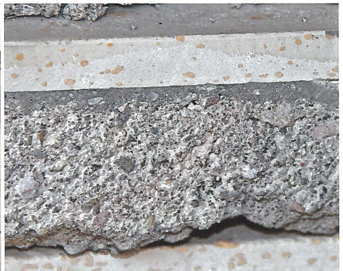
Bild 5: Guter Verbund des Rüttelbodens bei ausreichend dicker Haftschrämme.
