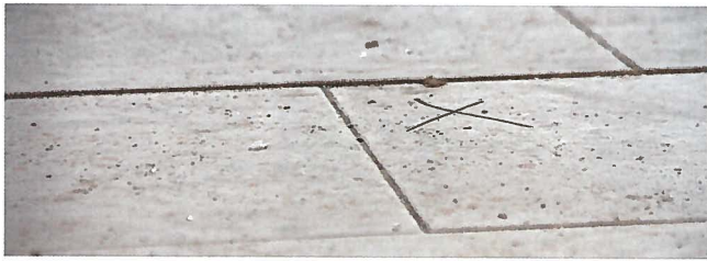
Bild 8: Höhenversätze benachbarter Platten.
