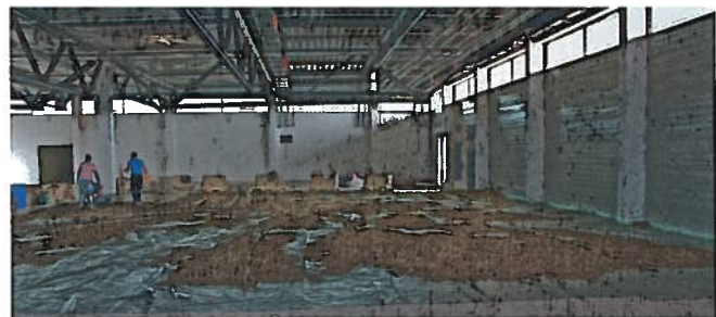
Abb. 1 a-c: »Verdursten« des vorgelegten Bettungsmörtels
