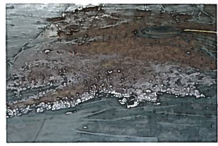
Abb. 1 a-c: »Verdursten« des vorgelegten Bettungsmörtels
