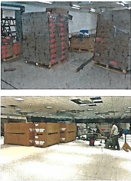
Abb. 8: Folgegewerke auf einem frisch hergestellten Rüttelboden
