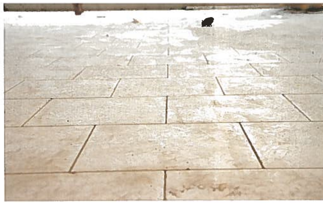
Halbverband mit Kantenwölbungen im Toleranzbereich der DIN EN ISO 10545
