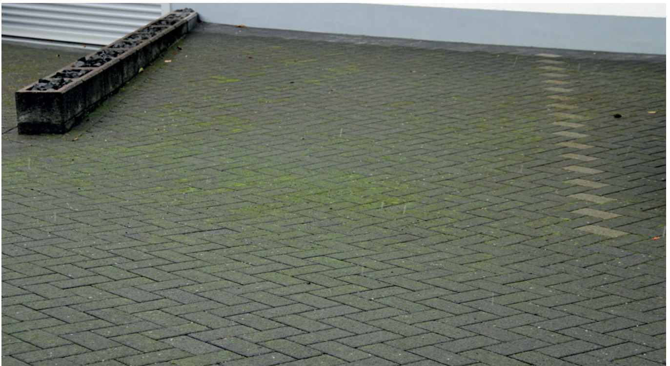
Abb. 10: Moosbewuchs durch fehlende Reinigung der Pflasterdecke
