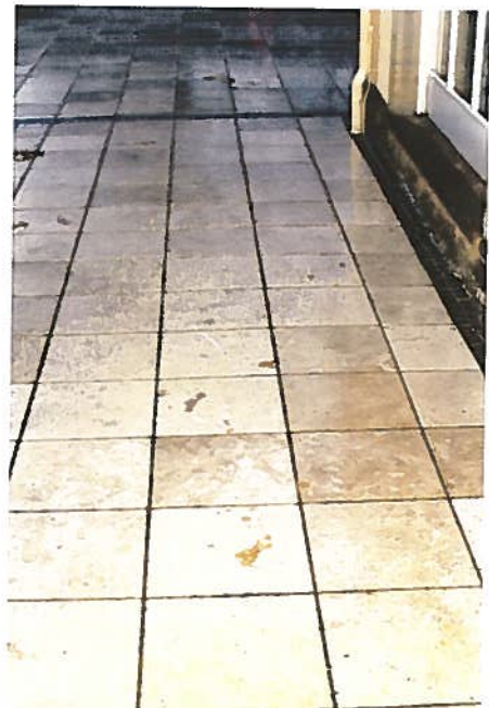
Abb. 4: Materialverluste an einem Kalkstein mit schichtbildender Oberflächenbehandlung (Foto: Henning Rohowski)
