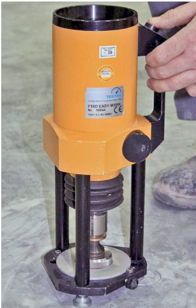
Durchführung der Abreißprüfung
