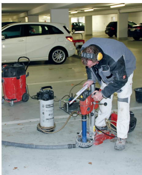
Vorbohren mit Fixierung des Bohrständers.
