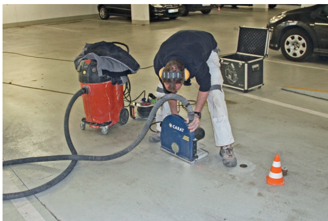
Einschneiden mit einem Trockenschneider mit Absaugvorrichtung.
