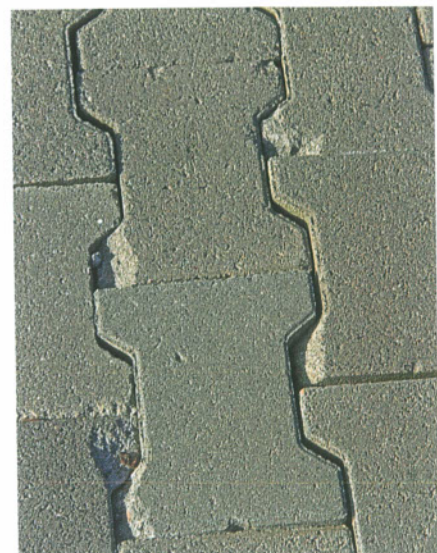
Abb. 4 a+b: Horizontalverschiebung der Pflastersteine sowie damit verbundene Kantenschäden
