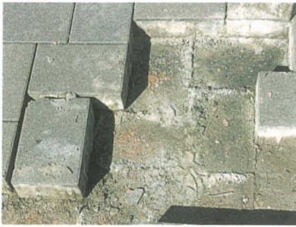
Abb. 5 a+b: »Abdichtung« der Bettung durch Verwendung kalksteinhaltiger Splitte
