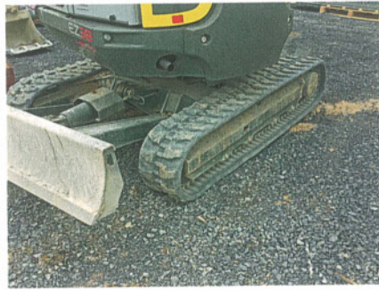
Abb. 3a+b: Zerstörung des Tragschichtmaterials in der Bauphase und Wasserstau in der Tragschicht
