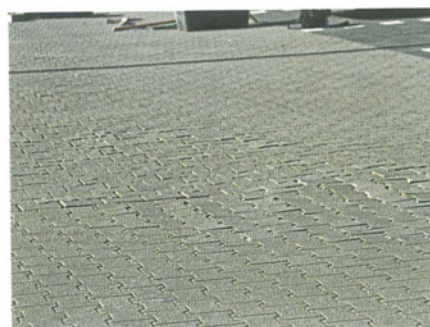
Abb. 4 a+b: Horizontalverschiebung der Pflastersteine sowie damit verbundene Kantenschäden
