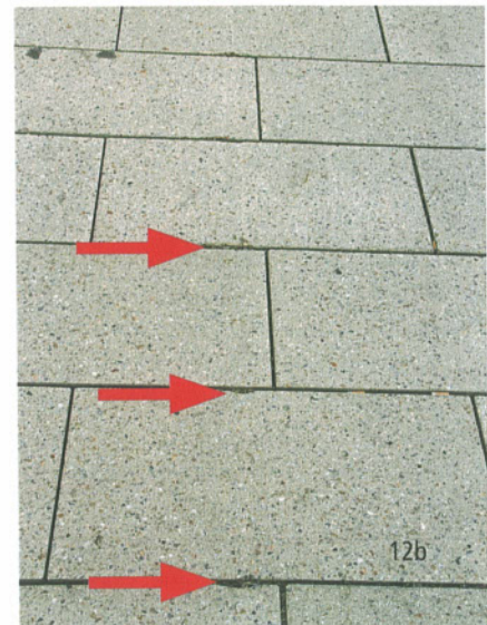
Abb. 12 a+b: Zwischenlagerung von Schuttcontainern auf der Flächenbefestigung
