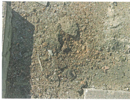
Abb. 5 a+b: »Abdichtung« der Bettung durch Verwendung kalksteinhaltiger Splitte
