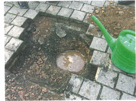
Abb. 3a+b: Zerstörung des Tragschichtmaterials in der Bauphase und Wasserstau in der Tragschicht
