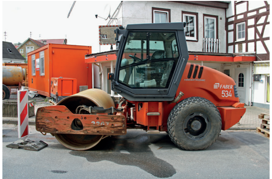
Abb. 11: Nicht sachgerechte Nutzung einer Flächenbefestigung in der Bauzeit
