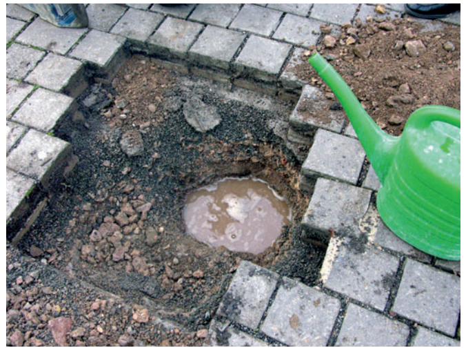
Abb. 3: Zerstörung des Tragschichtmaterials in der Bauphase und Wasserstau in der Tragschicht
