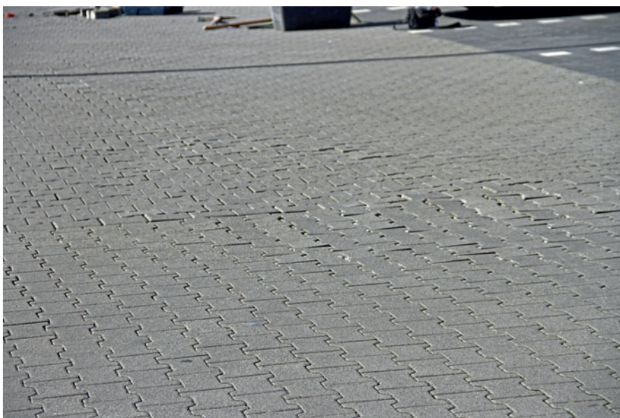
Abb. 4: Horizontalverschiebung der Pflastersteine sowie damit verbundene Kantenschäden
