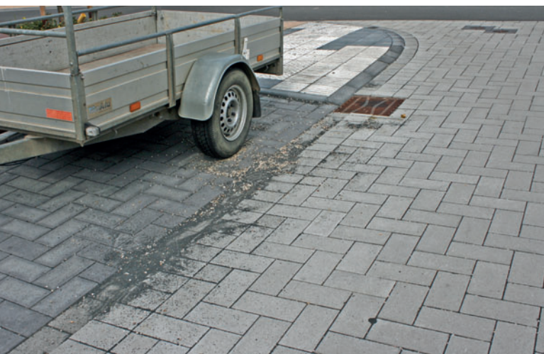
Abb. 15: Hohe Punktlasten durch Gesteinskörner
