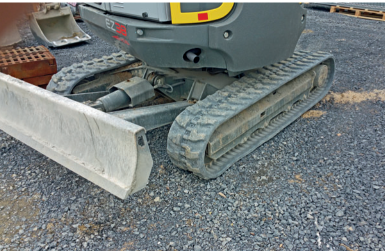
Abb. 3: Zerstörung des Tragschichtmaterials in der Bauphase und Wasserstau in der Tragschicht
