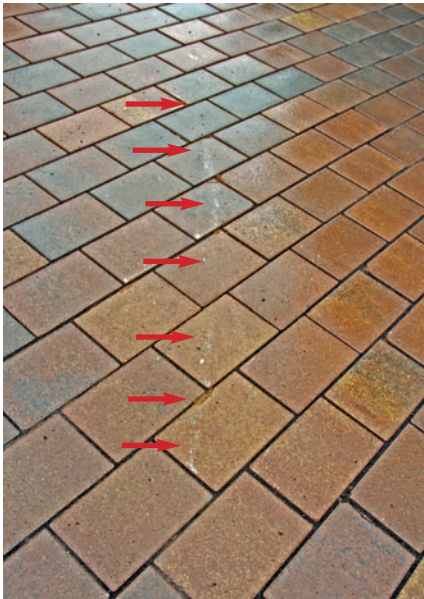
Abb. 11: Nicht sachgerechte Nutzung einer Flächenbefestigung in der Bauzeit
