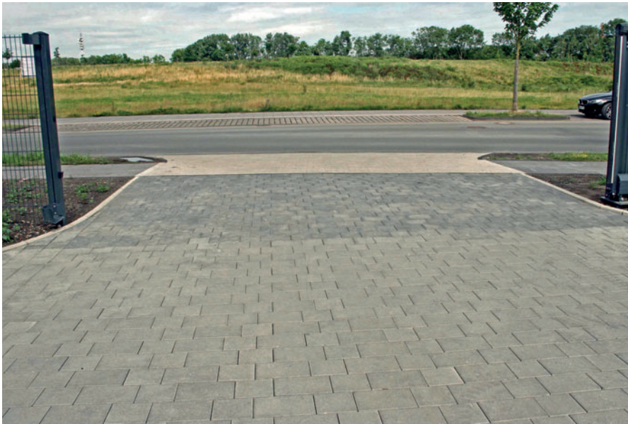
Abb. 6: Verfärbung von Steinoberflächen durch den Eintrag von Fugenmaterial links: Flächenbefestigung mit Verfärbungen durch das Fugenmaterial rechts: Einschlämmversuch eines kritischen Fugenmaterials auf einen sauberen Pflasterstein
