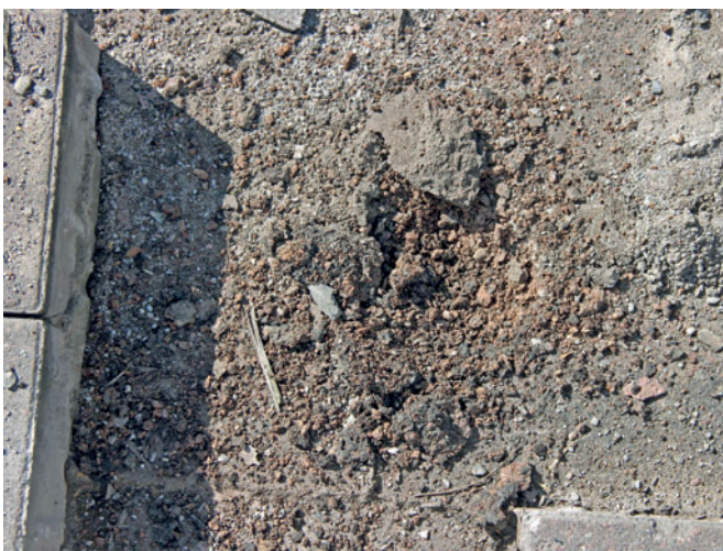
Abb. 5: „Abdichtung“ der Bettung durch Verwendung kalksteinhaltiger Splitte
