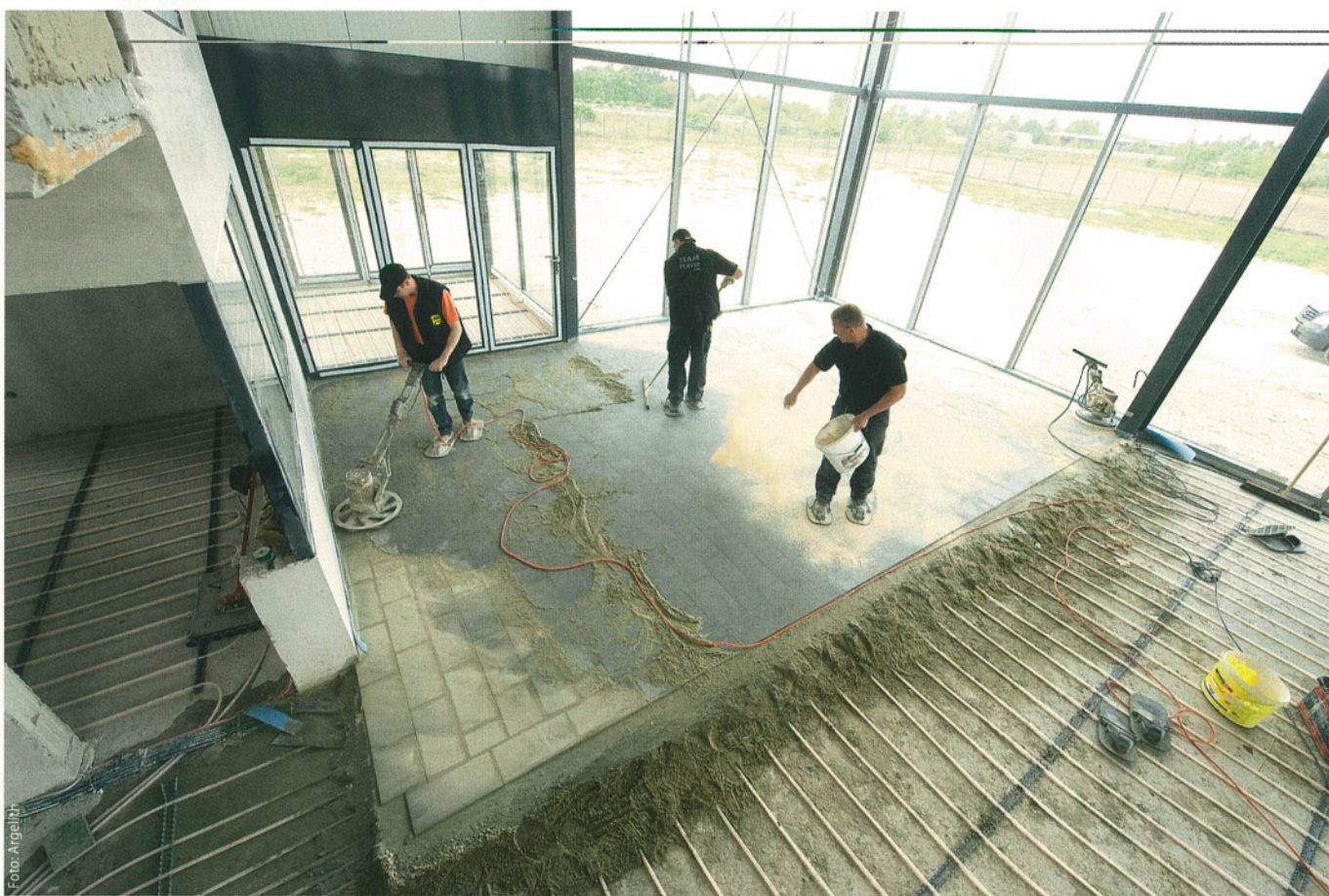
Entscheidend für die Biegezugfestigkeit eines Rüttelbodens ist der Verbund zwischen Bodenbelag und Estrich.
