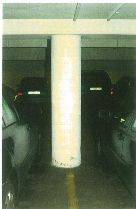
Bild 17: Mit der Potenzialfeldmessung zu untersuchende Stütze
