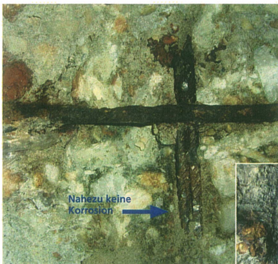
Bild 15: Bereiche mit chloridinduzierter Stahlkorrosion
