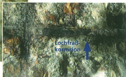
Bild 15: Bereiche mit chloridinduzierter Stahlkorrosion
