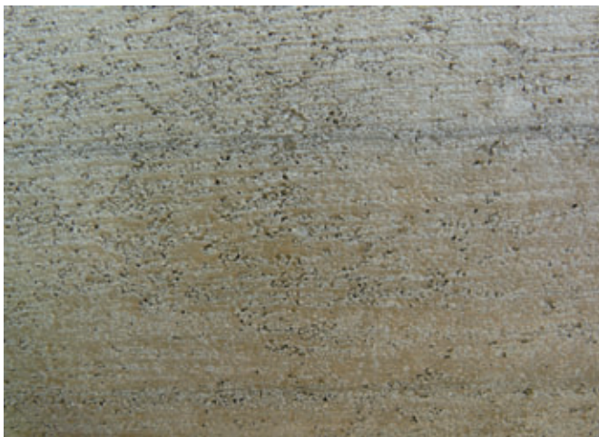
Abb. 11: Braunverfärbungen aufgrund fein verteilter eisenhaltiger Bestandteile
