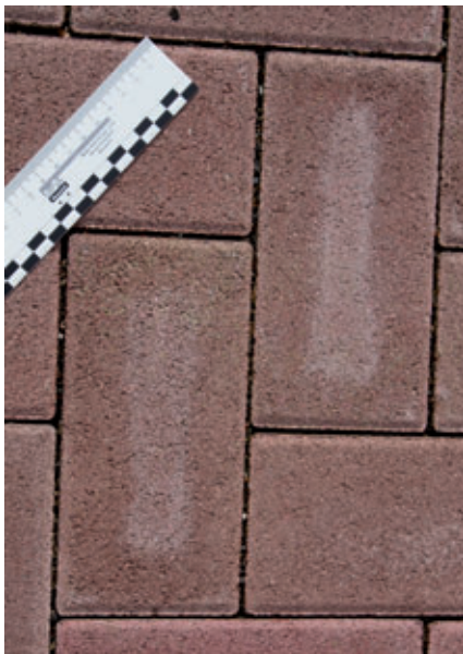
Abb. 1: Baustofftypische Carbonatausblühungen
