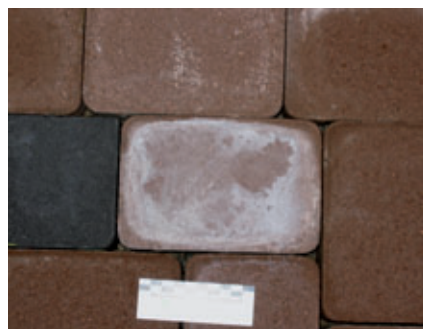
Abb. 3: Massive Carbonatausblühungen
