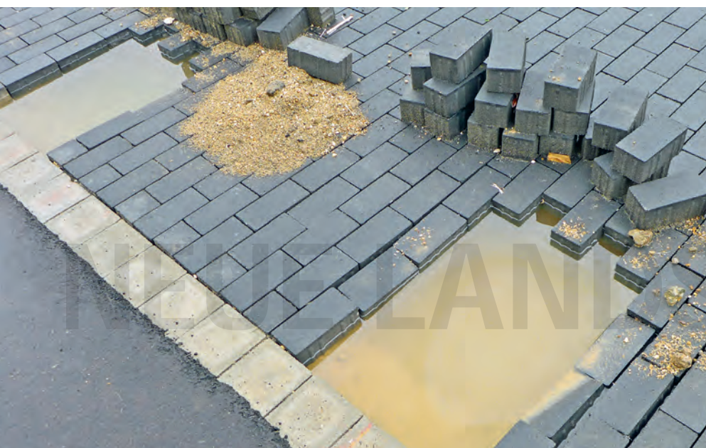
7. Verfestigte, wasserundurchlässigen Bettung.
