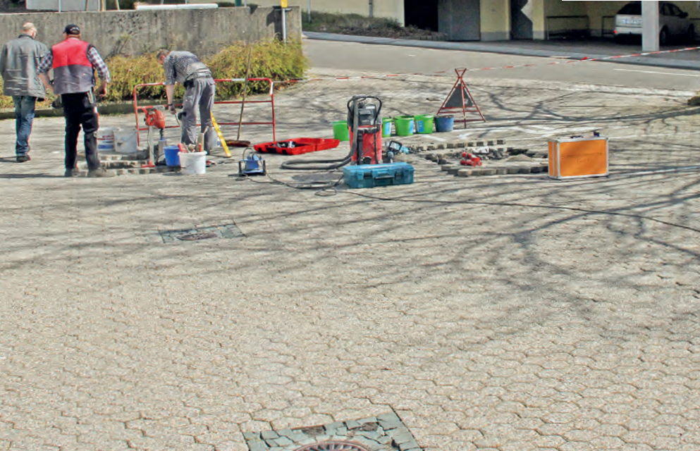
6. Pflasterdecke auf einer Tiefgarage.
