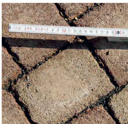
1. Erwartungsgemäße (baustofftypische) Verfärbung durch Ausblühungen. Fotos: Karl-Uwe Voß
