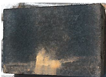
Abb. 10 a+b: Verschmutzter Gehweg und verschmutzte Lagerware – oben verschmutzter Gehwegbereich / unten: auf Paletten gelagerte unverbaute Betonplatten
