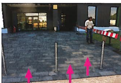
Abb. 9: Flächenbefestigung mit den verschmutzten anthrazitfarbenen Betonplatten
