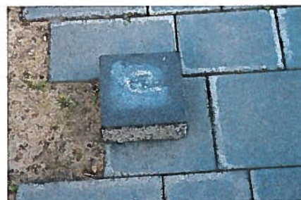
Abb. 2: Farbunterschied zwischen einer Rückstellprobe und den Steinen der Flächenbefestigung
