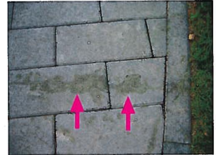
Abb. 14: Verschmutzungsquelle: Grünschnitt
