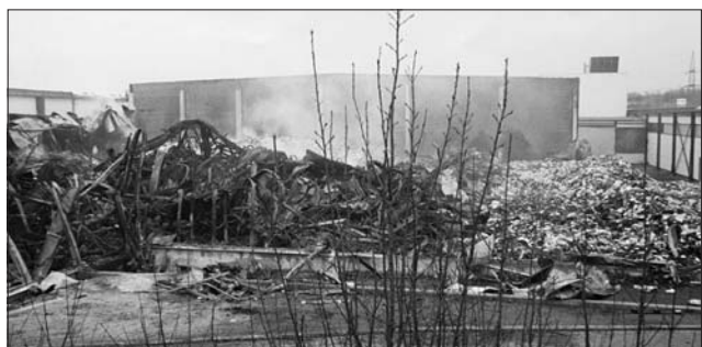
Bild 7. Brandwand einer Industriehalle nach dem Feuer von Bild 6 Fig. 7. Fire retaining wall after the fire of fig. 6.
