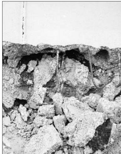
Bild 3. Bewehrungsverankerung durch Haken und Korrosionsschutz durch Zementleimüberzug.
