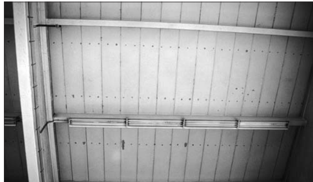
Bild 9. Befestiger für Dachabdichtung ähnlich einer Niete. Fig. 9. Fixing of water-proofing membrane similar to rivets.
