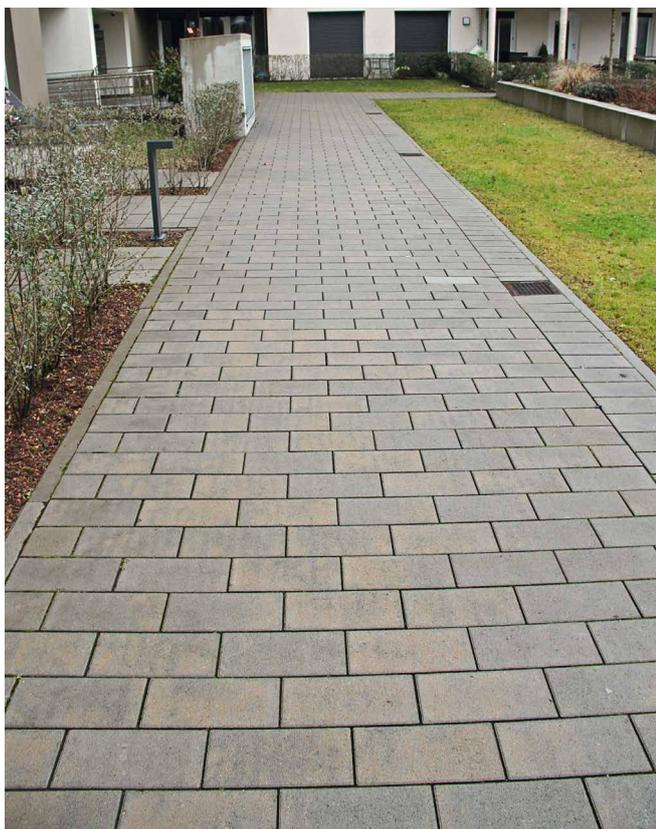
Abb. 3 a+b: nicht durch PKW oder andere Fahrzeuge erreichbare Pflasterdecken
