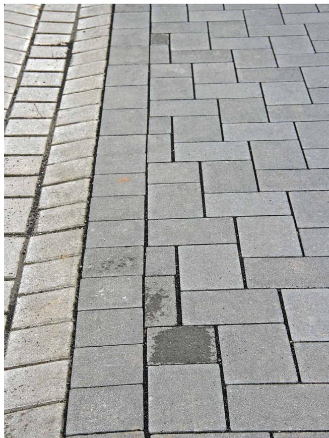
Abb. 1 a+b: aufgrund der Fugenbreite reklamierte Pflasterdecke
