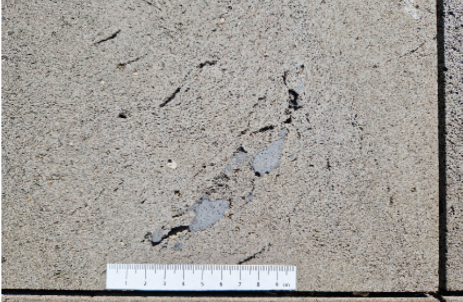
Bild 80 Gespachtelte Oberfläche [Quelle: La Bouchardiere]
