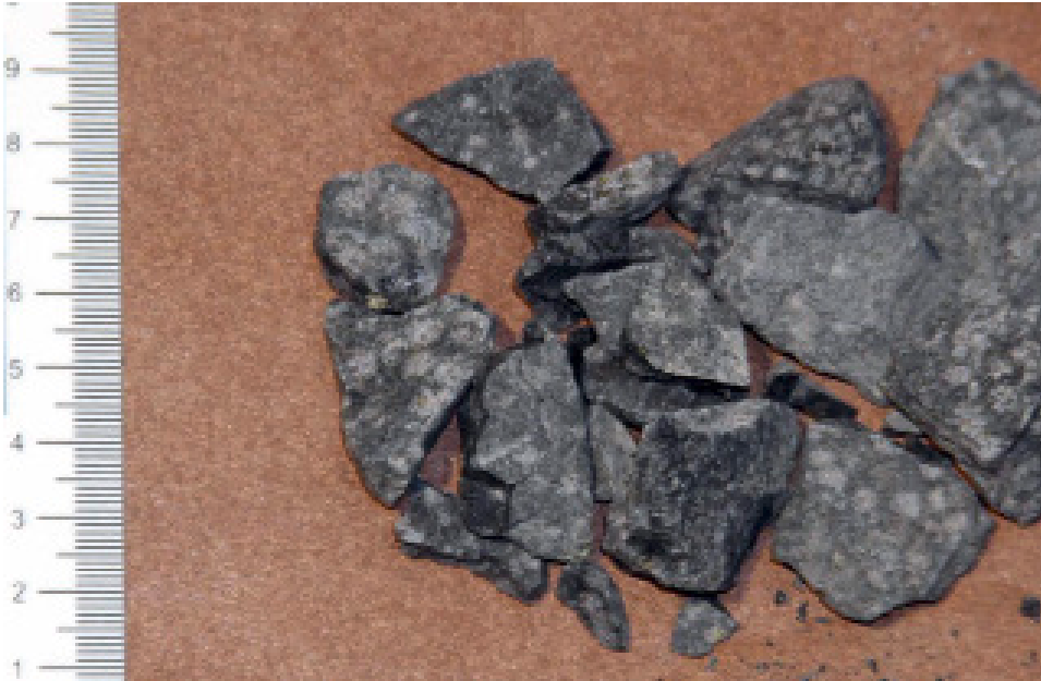
Bild 57 Gefügezerstörung durch Sonnenbrand [Quelle: Rohowski]
