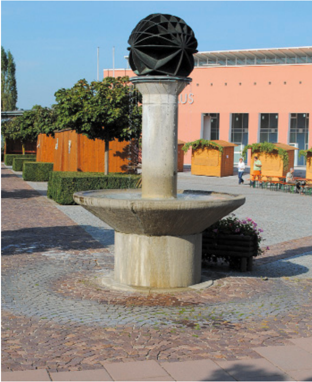
Bild 120 Lösliche Bestandteile, die sich aus Grund-, Leitungs- und/oder Brunnenwasser auf der Oberfläche ablagern, hier aus kalkhaltigem Wasser [Quelle: Henn]
