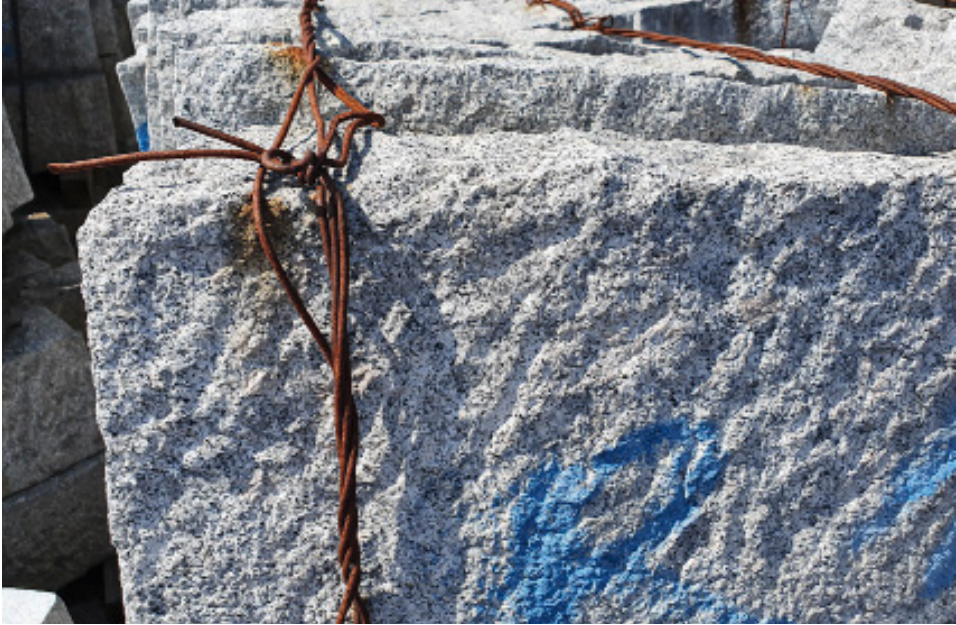
Bild 79 Verfärbung durch rostende Stahldrähte [Quelle: La Bouchardiere]
