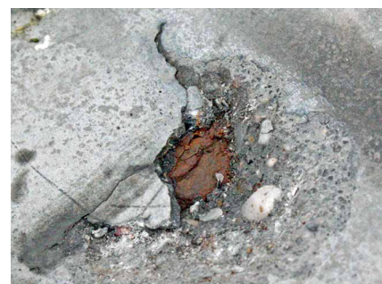
Abb. 28: Zementsteinabwitterungen oberhalb einzelner verwitterungsunbeständiger Gesteinskörner
