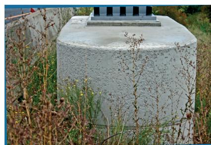
Abb. 4 a+b: Frost-Tausalz-bedingte Abwitterungen auf den vertikal ausgerichteten Flächen des Fundamentes eines Verkehrszeichenträgers
