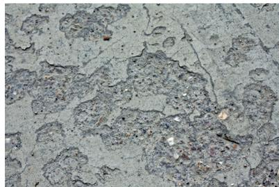
**Abb. 1 a+b:** Abplatzung des oberflächennahen Zementsteins
