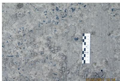
Abb. 3 a+b: Über die Fläche verteilt auftretende, flächige Abwitterungen
