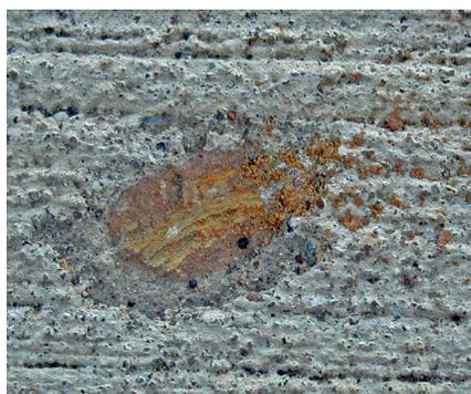
**Abb. 11 a+b:** Zementsteinabwitterungen oberhalb witterungsunbeständiger Gesteinskörner
