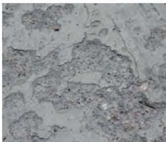
Bild 1: Abplatzung des oberflächennahen Zementsteins
