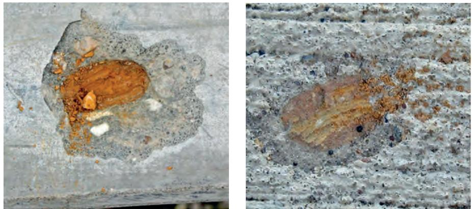
Bild 11: Zementsteinabwitterungen oberhalb witterungsunbeständiger Gesteinskörner
