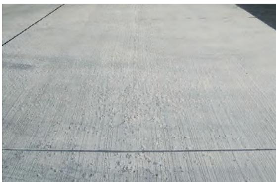
Bild 14: Abwitterungen in der Oberfläche aufgrund eines nicht sachgerecht ausgeführten Besenstrichs
