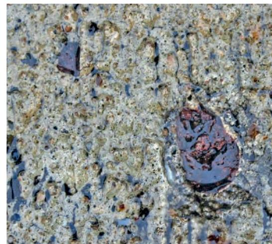
Bild 5: Zersetzliches Gesteinskorn im Zentrum einer Zementsteinabwitterung
