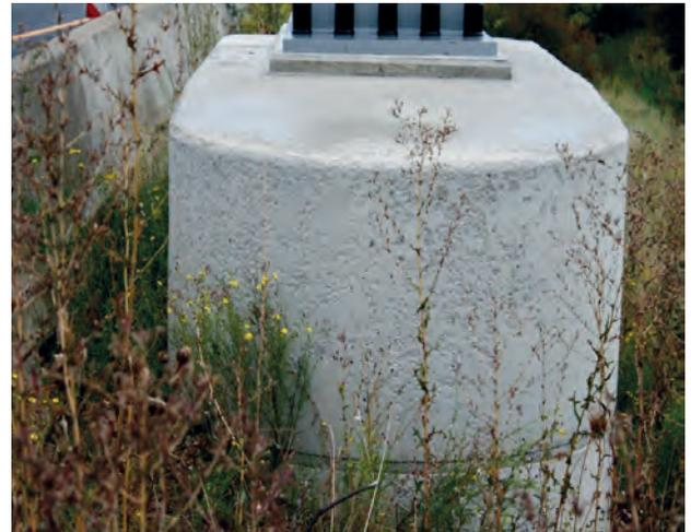
Bild 4: Frost-Tausalz-bedingte Abwitterungen auf den vertikal ausgerichteten Flächen des Fundaments eines Verkehrszeichenträgers
