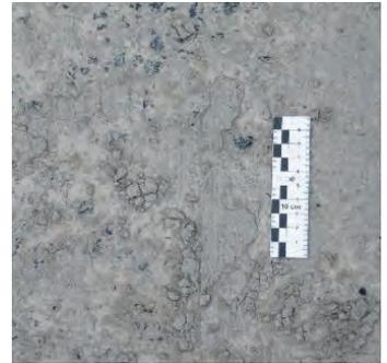
Bild 3: Über die Fläche verteilt auftretende, flächige Abwitterungen
